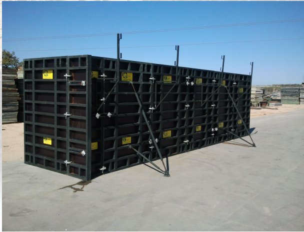
Montage type du système MULTIMAX.
